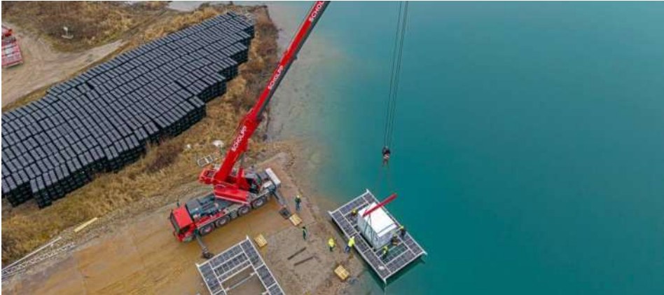
Auf einer Fläche von 3,4 Hektar soll eine schwimmende PV-Anlage entstehen, die eine Leistung von sechs Megawatt hat und zwei Industriebetriebe versorgt. Foto: Erdgas Südwest
